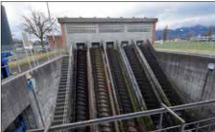
Danach fließt das Abwasser durch den Grobrechen. Bei diesem werden die groben Schmutzstoffe wie Holz, WC-Papier, Feuchttücher und Speisereste aus dem Abwasser gefiltert. Beim belüfteten Sand- und Ölfang ist die Fließgeschwindigkeit so gering, dass sich feiner Kies und Sand absetzt. Die Belüftung ist so reguliert, dass sich einerseits Sand und andererseits Feststoffe absetzen können, während das Öl in der Schwebeliege bleibt.
