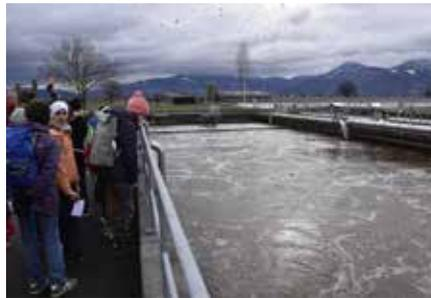
In einem Becken wird Sauerstoff hineingepumpt, und im anderem nicht, weil die anderen Bakterien das nicht mögen. Im Nachklärbecken, das ist ein Becken weiter, sinken die Bakterien zu Boden, weil es nicht belüftet oder schnellbewegt wird. Dadurch, dass im Nachklärbecken ein Schieber die Bakterien zurückschiebt, können sie wiederverwendet werden. Danach wird das Wasser in den Binnenkanal geleitet. Das Wasser im Nachklärbecken kann man aber immer noch nicht trinken!!!
