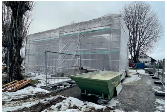
Sanierung Kindergarten Eichholz
